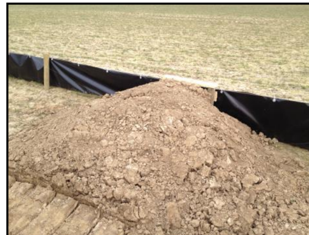
Photo 5C : Barrière à amphibiens seule accompagnée d'échappatoires (Rainette)
