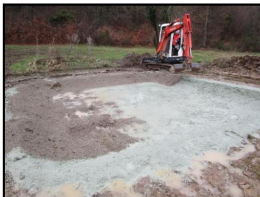
Photo 4 : Dépôt d'une couche de sédiment sur le lit de bentonite
