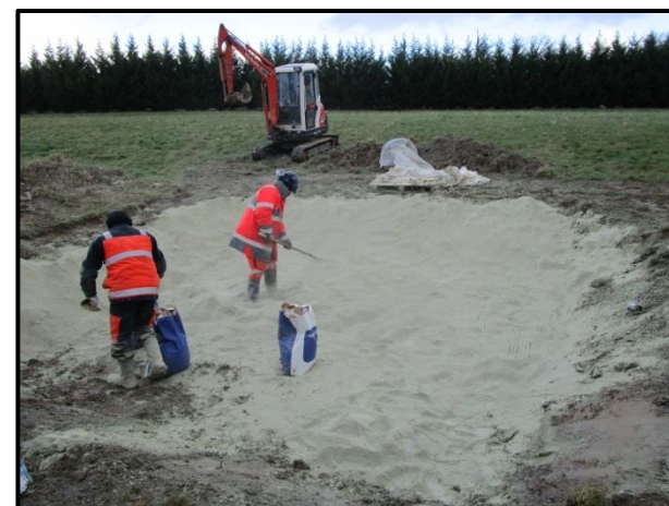
Photo 17C : Dépôt d'une couche de bentonite imperméabilisante
