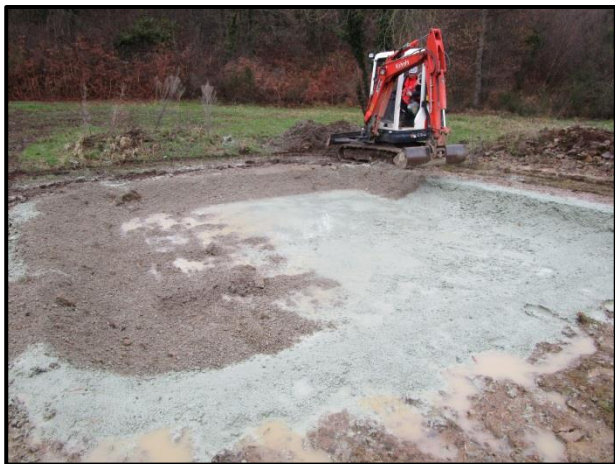
Photo 18C : Dépôt d'une couche de sédiment sur le lit de bentonite
