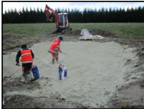
Photo 3 : Dépôt d'une couche de bentonite imperméabilisante
