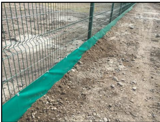
Photo 6C : Barrière à Amphibiens en complément de l'emprise chantier (Rainette)
